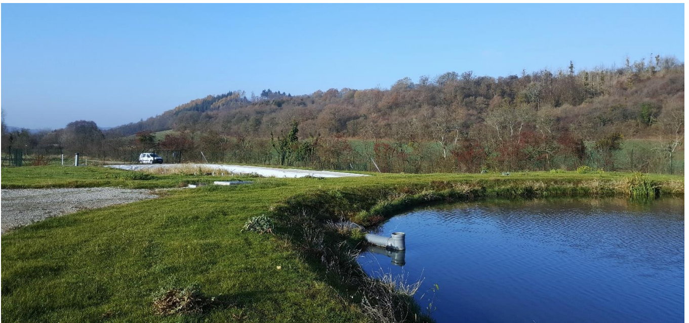
Lagunage et lit planté de roseaux – station d'épuration de Budling
