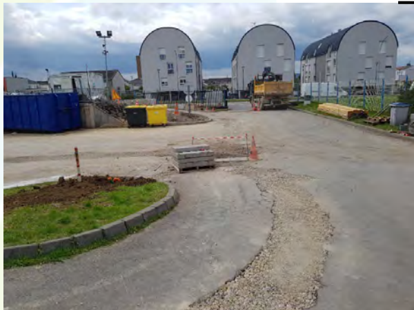
Fouilles pour le câblage des équipements de contrôle d'accès
