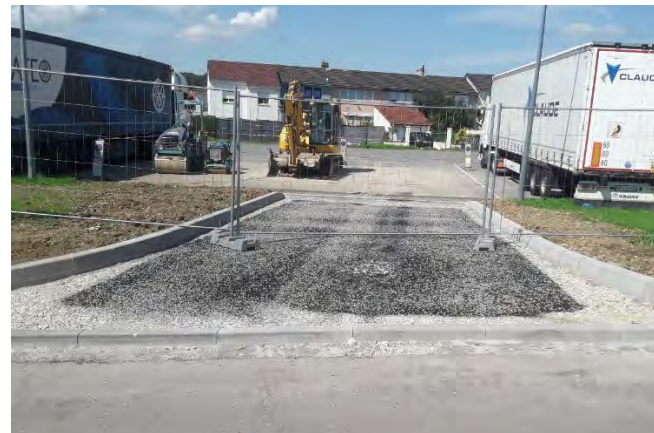
Réalisation de la voie d'accès
